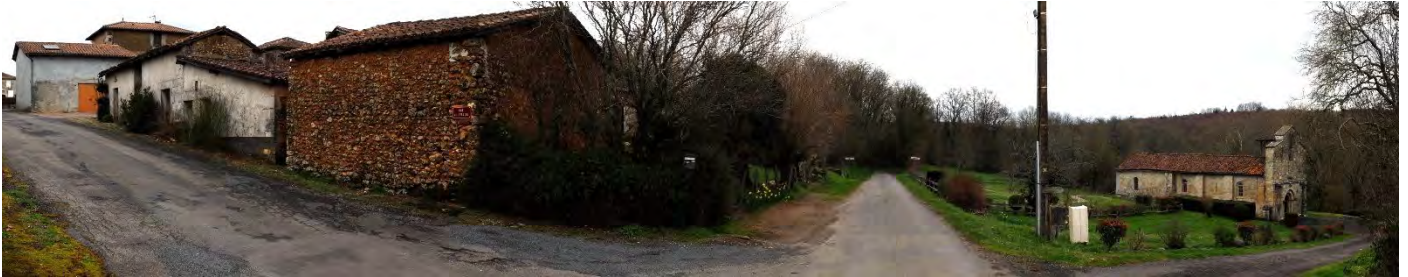
photo : une façade non-enduite qui laisse apparaître l'appareillage de pierre et la terre argileuse.
