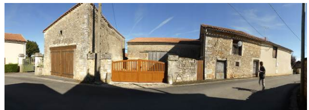
Parement à « pierres vues ». Dépendances de ferme au bourg de Saint-Projet. Cl. B. Wagon, 2013.
