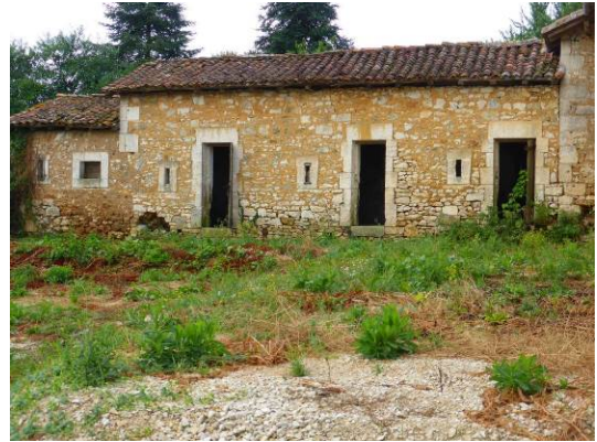
Parement à « pierres vues ». Dépendances de la ferme des Faures. Cl. V. Rousset, 2013.
