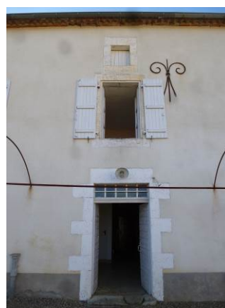
Parement en maçonnerie moellonnée enduite. Logis de la ferme de Lériget. Cl. B. Wagon, 2013.
