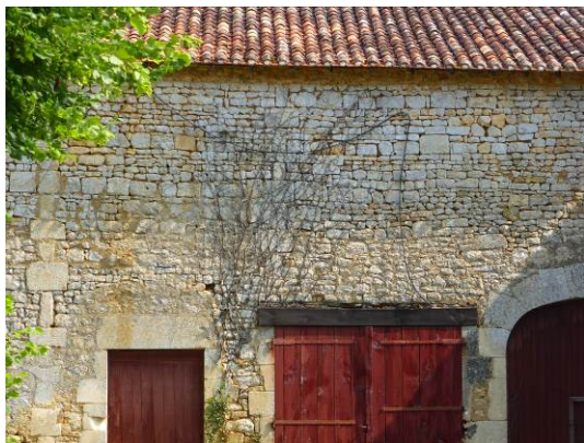
Parement en moellons apparents, taillés et assisés. Dépendances du château des Ombrais. Cl. B. Wagon, 2013.
