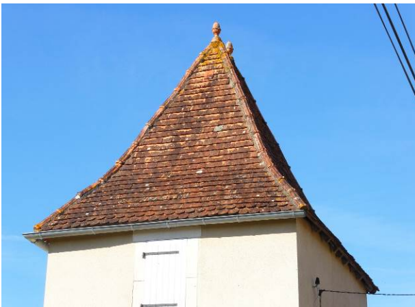
Quelques rares exemplaires de couvertures en tuiles plates, pour les couvertures à forte pente.
