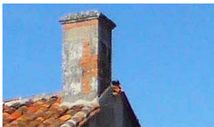
Souche de cheminée avec couronnement mouluré par débords, carrées ou rectangulaires,
