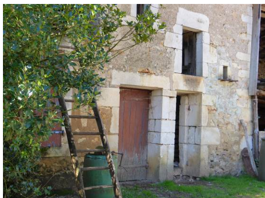
Parement en maçonnerie en moellons enduite (dépendance de ferme). Ferme de Jean Juzeau au bourg de Saint-Projet. Cl. V. Rousset, 2013.
