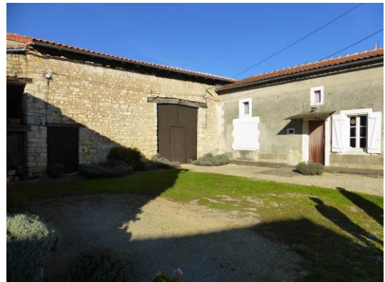
Parement en moellons et enduit à « pierres vues ». Grange-étable de la ferme de Saint-Constant. L'habitation à façade en moellons est enduite. Cl. V. Rousset, 2013.
