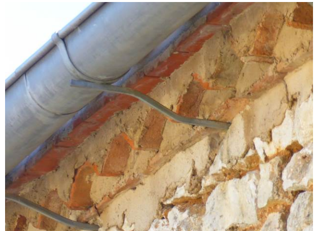
Génoise en tuile et brique en rive de couverture.
