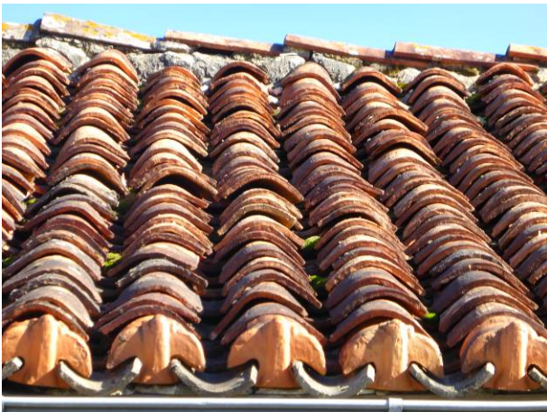
Tuiles canal en tuiles de courant et tuile de couvrant séparées, avec fermeture décorative des embouts, dits « nez-de-gorets ».
