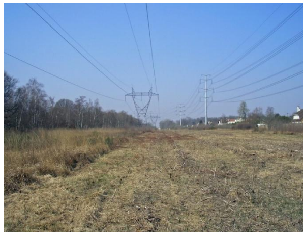
Figure 33 : lignes Les lignes électriques constituent des barrières pour la faune aérienne. © Romain Sordello
